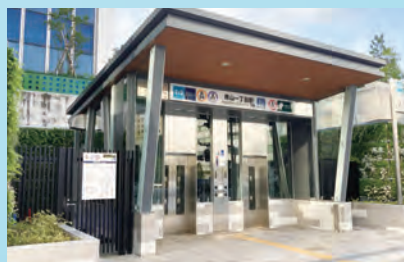
エレベーターの整備（青山一丁目駅）
